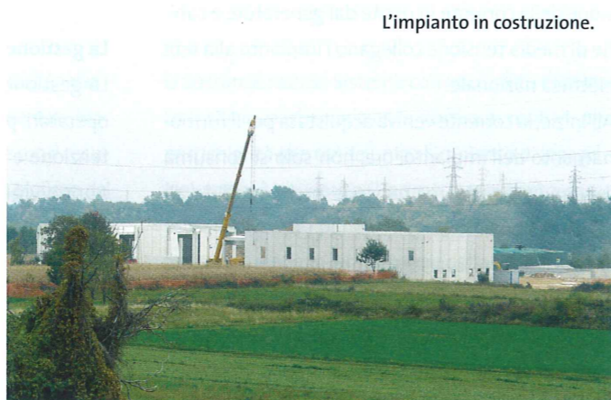
L'impianto in costruzione.
